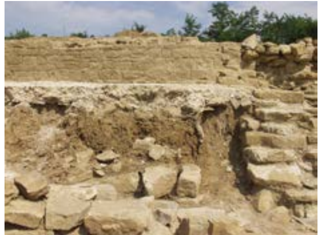
59 Presek maltnih podlag SE 327 nad coklom zidu.
