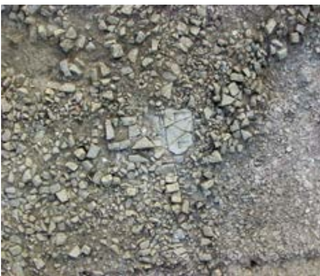
385 Ruševine na območju terase 2. Vidni so ostanki zidu SE 622A.
