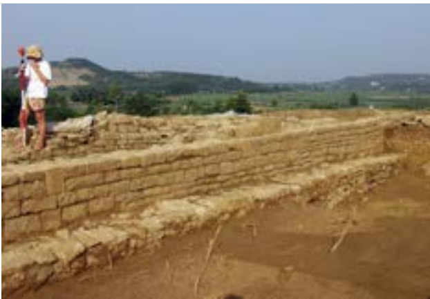
26b Zunanja stena gospodarskega poslopja v 1. fazi – zid SE 366 z dobro vidnim coklom temelja. Kasnejši prostor B. Pogled proti zahodu.
