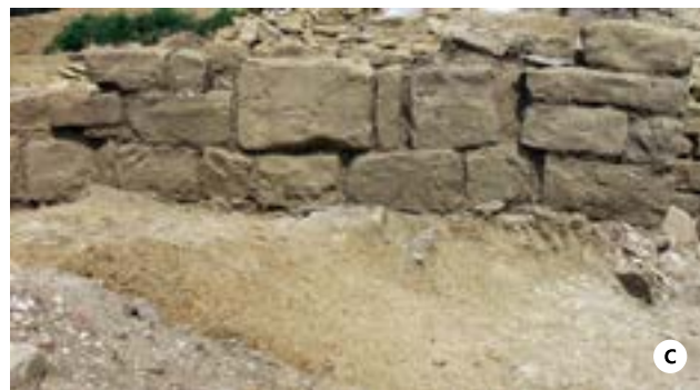
300 Struktura SE 292: a – navpični pogled s severovzhoda, b – jugovzhodno lice, c – jugozahodno lice.
