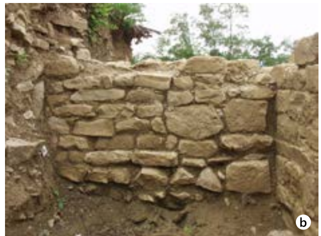
253 Zid SE 344: a – v prostoru BB; b – v prostoru J.
