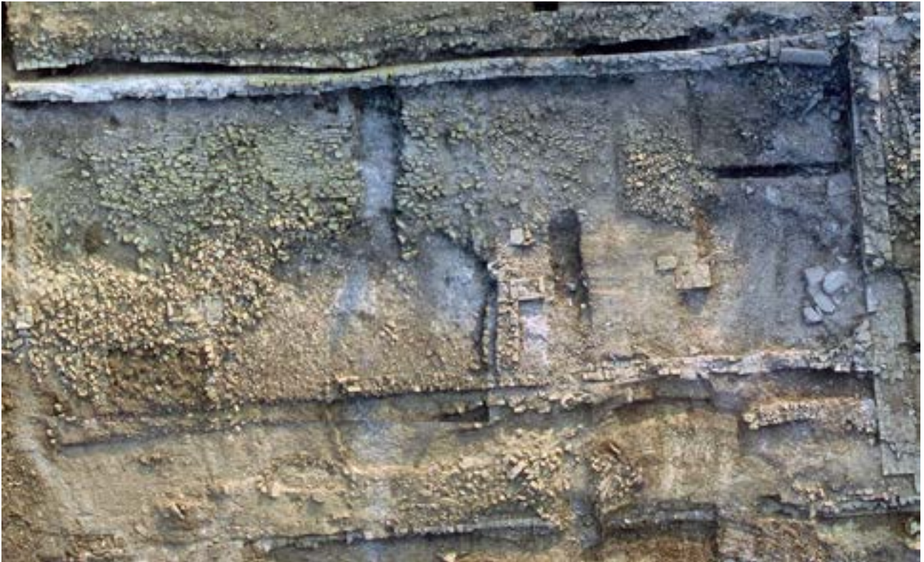
376 Ruševina v skladišču.
