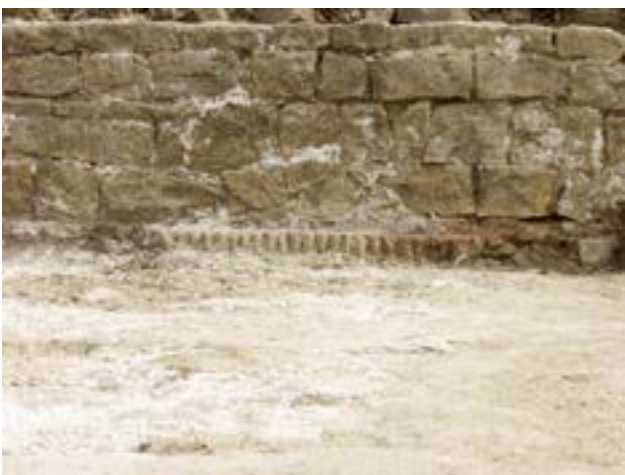
63 Ohranjeni tlakovci ob zidu SE 330. Viden je tudi omet na steni.
