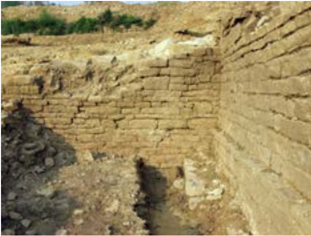
26a Zid SE 310 = SE 366 v skladišču (1. faza), pogled proti severovzhodu.
