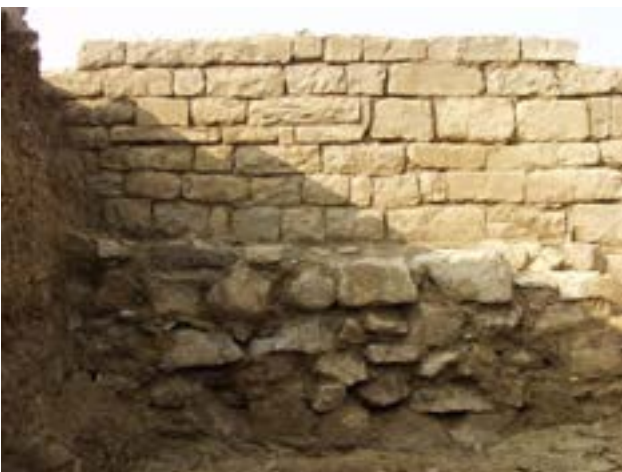
26c Jasno vidna razlika v gradnji lica zidu in temelja zunanje stene gospodarskega poslopja v 1. fazi – zid SE 366, pogled proti jugozahodu.
