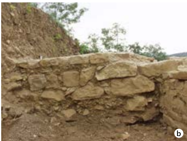
254 Zid SE 313: a – v prostoru J, b – v prostoru E.
