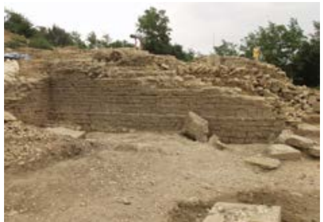
123 Zid SE 363 = SE 257 v skladišču.
