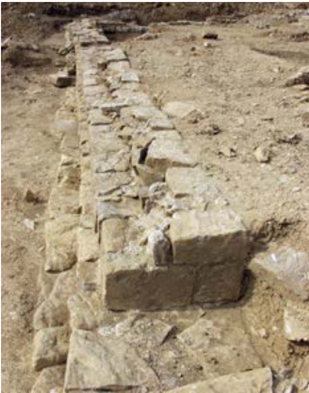
108 Vhod v zidu SE 208 iz notranjega dvorišča. Skrbno postavljeni kamni ob podboju na severozahodni strani.
