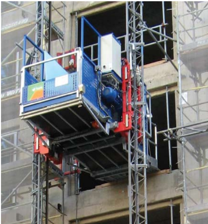
Slika 1: Na področje uporabe novega pravilnika sodijo po novem tudi začasna dvigala za prevoz tovora in oseb na gradbiščih.
