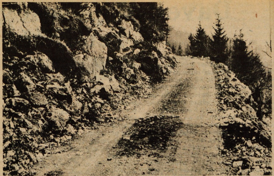
Skupščina občine Kranj se je odločila, da predvsem zaradi prevoza otrok v cerkljansko osnovno šolo uredi cesto na Šentursko goro. Skupščina je popravilo ceste zaupala gradbenemu obratu Gozdnega gospodarstva Kranj. Popravljena cesta bo široka 5 metrov in bo omogočala tudi avtobusni promet. Razen tega bodo razširjeni tudi ovinki. Na Gozdnem gospodarstvu Kranj so nam povedali, da bo prvi odsek ceste od Grada do odcepa za Stiško vas urejen že do 1. maja. (jk) — Foto: F. Perdan
