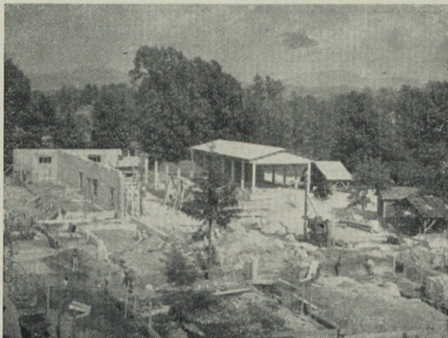
Gradnja delavnic (posneto začetkom junija 1960)
