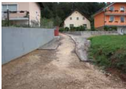
Obnova hišnih priključkov
