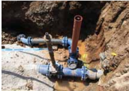
Izvedba začasne in nove povezave vodovoda
