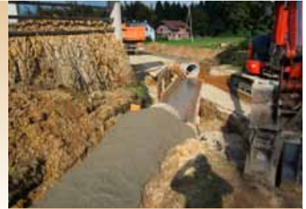
Temeljna plošča prepusta.
