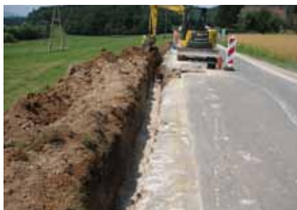
Cevovod v zaščitnem obsipu
