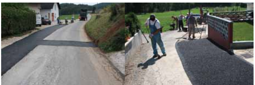
Po končanih gradbenih delih še urejanje cestišča in hišnih priključkov
