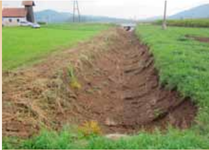
Čiščenje kanala z odmetom na rob.
