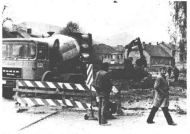
Zaradi gradnje kolektorja je zaprta Kajuhova cesta
