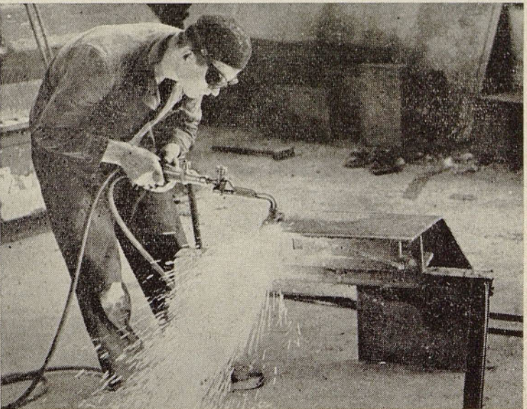
Priprava jeklene pločevine za katodno omaro
