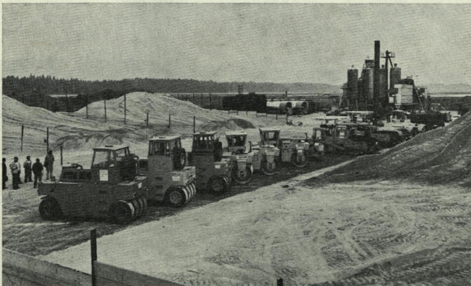
Sl. 6. Del mehanizacije za asfaltna dela, deponirane pred pričetkom del na prostoru asfaltne baze WIBAU (kapacitete 100 ton/h) na samem letališču Brnik
