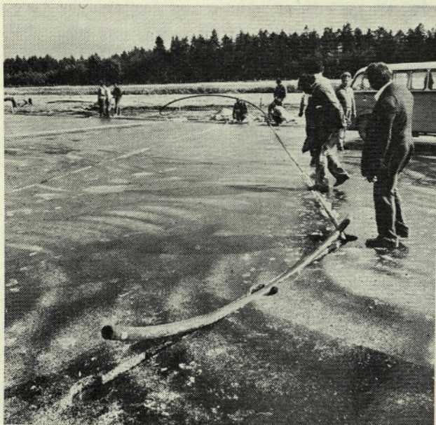
Sl. 1. Polaganje alcaten cevi (14.000 ml) v izrezane utore na VPS
