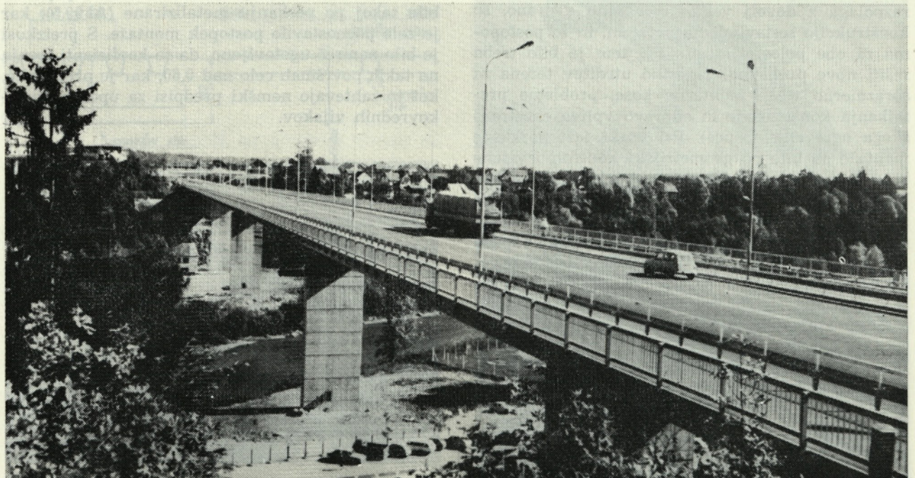
Slika 9. Pogled na gotov most
