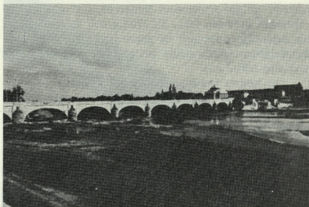
Slika 1. Most čez Loire v Toursu. Skrajnj desnobrežni del je porušen
