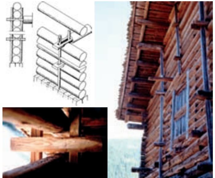
Fig. 11: Use of vertical elements to improve the horizontal stability of the logs. Uporaba vertikalnih letev za izboljšanje horizontalne stabilnost brun.
