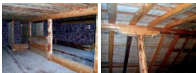
Fig. 15: Left: Double warping with pillar supporting the main beam. Right: Double roof frame with rafters and supported ridgepole. Levo: Steber podpira glavni tram vmesne konstrukcije. Desno: Dvojna strešna konstrukcija špirovcev s podprto slemensko lego.
