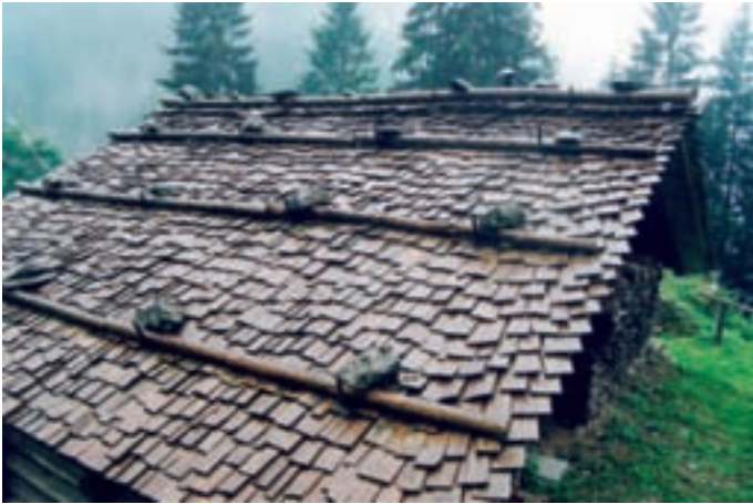
Fig. 19: Slim logs holding the shingles. Ozka bruna učvrščujejo (drijo) skodle.
