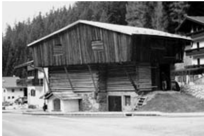
Fig. 28: Typical covered overhang in Val di Fassa. Značilni pokriti napušči določajo fasado, Val di Fassa.
