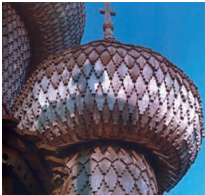
Slika 1: Strehe lesenih čebul, cerkev v Kizhi. Dekoracija služi odvodu vode. Coupolas of the Church of the Transfiguration in Kizhi.
