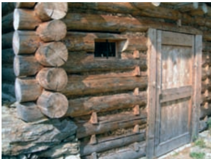
Fig. 25: Detail of a window protected with iron bars. Detajl zaščite okenske odprtine s kovinsko rešetko.
