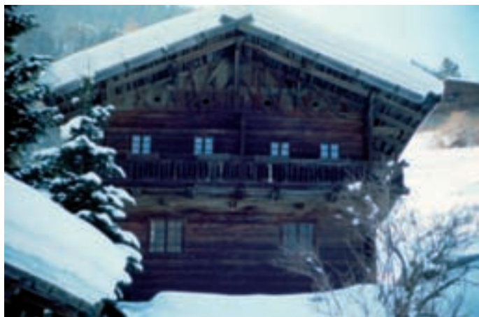
Fig. 2: Residential building in the blockbau system in Val d'Ultimo. Hiša narejena v kladni zvezi, Val d'Ultimo.
