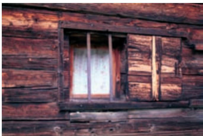
Fig. 26: Detail of a window protected with iron bars. Detajl zaščite okenske odprtine s kovinsko rešetko.
