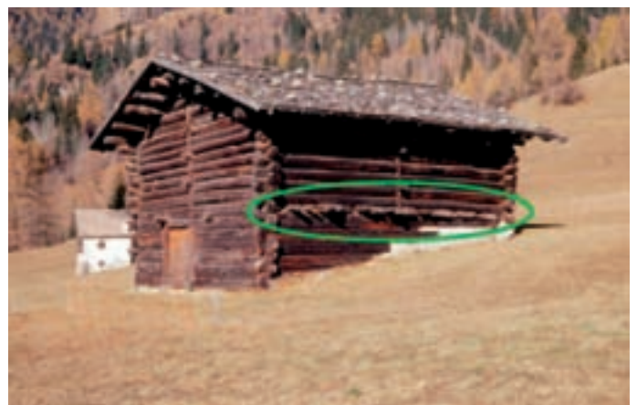
Fig. 13: The "cornice" of wooden floor elements (Val di Fiemme). Zaključki (glave) lesenega poda (Val di Fiemme).
