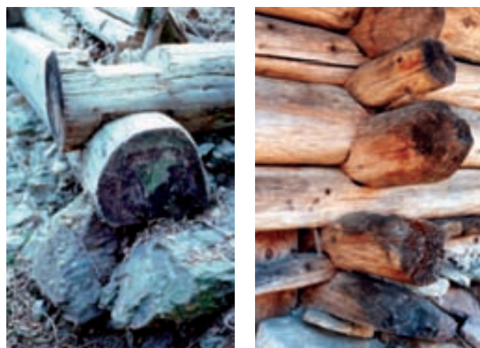
Fig. 7: Example of corner joints with notches on either the upper or lower logs. Primer vogalnih stikov lesa ob stiku tako na zgornji kot na spodnji strani.
