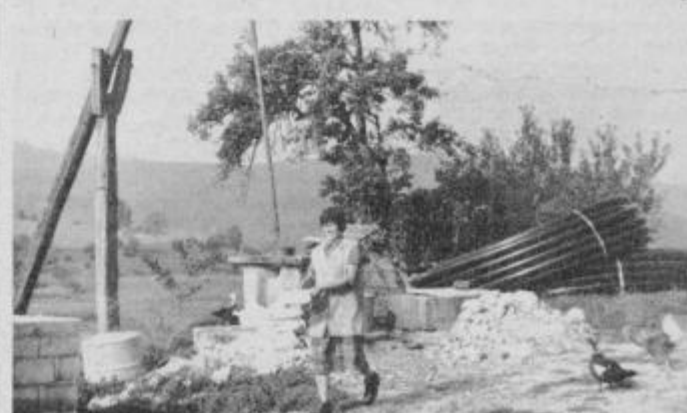
Deževnico iz vodnjaka bo kmalu zamenjala voda iz vodovoda. Foto: F. Prelog
