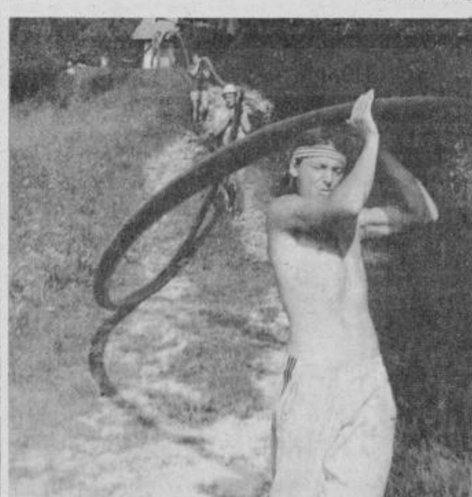
Brigadirji MDB Jože Lacko nesejo razvito cev za primarni vodovod do jaška. Foto: F. Prelog
