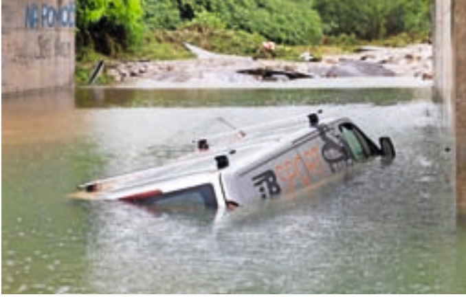
Zalit podvoz pod železniško progo v Goričanah, ki je še vedno zaprt / Foto: Peter Košenina
