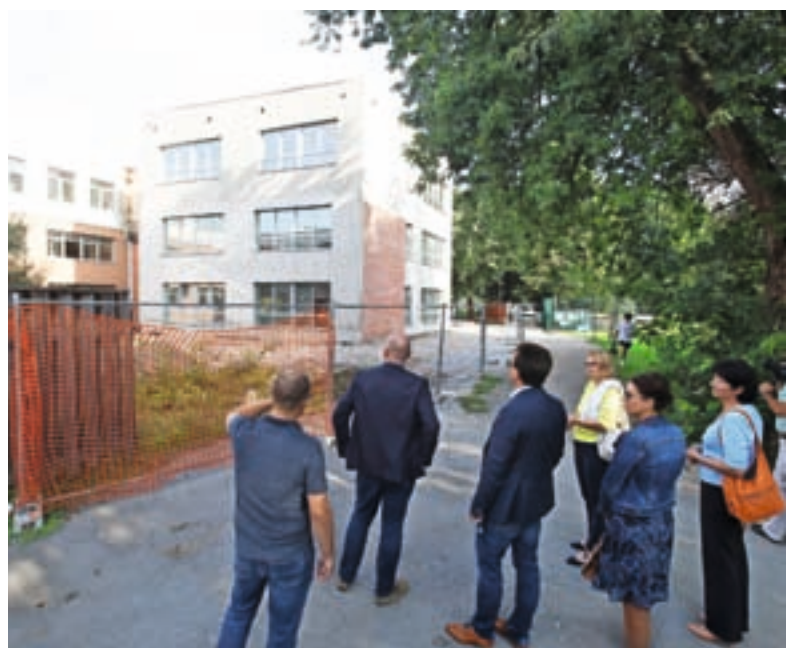
Župan Nejc Smole je s sodelavci obiskal tudi OŠ Jela Janežiča v Škofji Loki. Gradnja prizidka tam še ni zaključena. / Foto: Gorazd Kavčič
