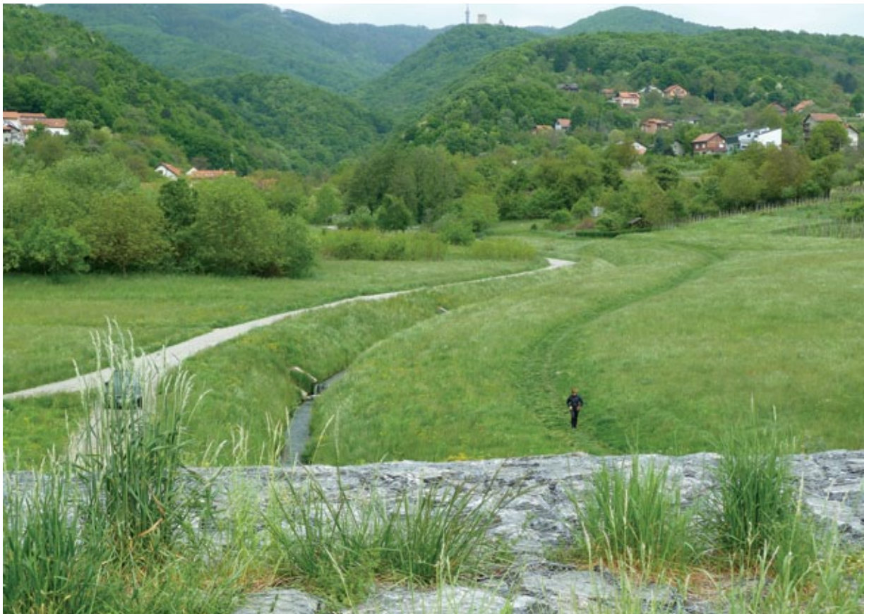
Slika 1: Protipoplavni zadrževalnik na Velikem potoku nad Zagrebom – pogled s pregrade gorvodno (foto: Karel Natek).
