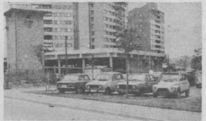
a v gradnji je nova, večja. (S. C.)
