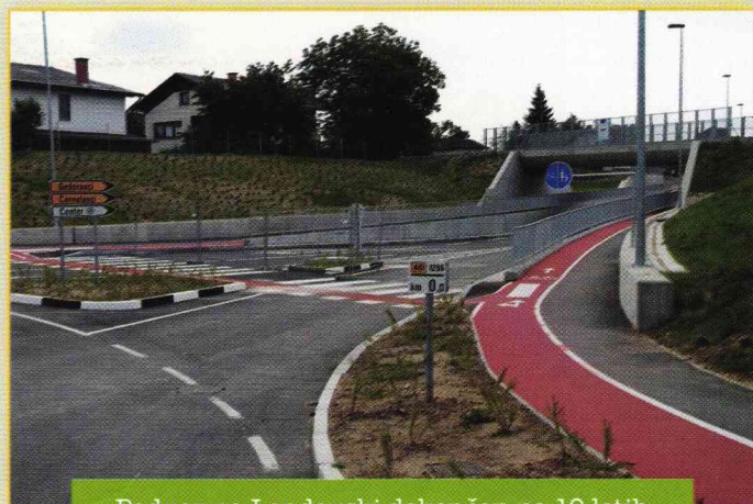
Podvoz na Lendavski dokončan po 10 letih
