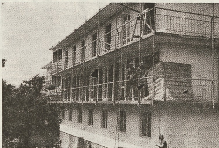
Delavci iz obrata »Mizarstvo« v Umagu pri gradnji hotela
