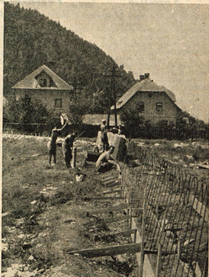
LJUJSKA TEHNIKA GRADI NA STADIONU »MLADOST« V STRAŽIŠČU MODERNO DIRKALIŠČNO STEZO. TO BO PRVA TAKA STEZA NA GORENJSKEM. DOGRAJENA BO V JULIJU, KER TAKRAT ŽE PREDVIDEVAJO PRVE MEDNARODNE AVTO-MOTO DIRKE. VSEKAKOR JE TO POMEMBNA PRIDOBITEV ZA KRANJ IN LEPA POCASTITEV 10. OBLETNICE LJUJSKE TEHNIKE.
