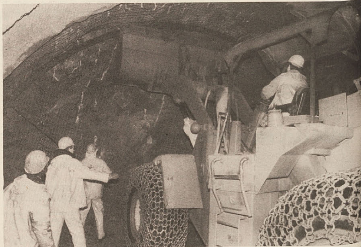
Na sliki: delavci postavljajo obodni lok, s katerim so pritrjene železne mreže. Delo je nevarno in od ljudi ter strojev zahteva vse.
