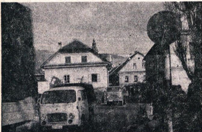
Stara ETA pred rušenjem?
