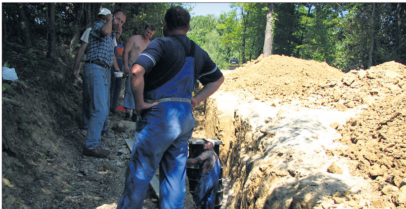
Dela na polkilometrskem kanalizacijskem vodu v smeri proti OŠ, kjer se bo priključil na čistilno napravo, so v polnem teku; hkrati s položitvijo kanalizacijskih cevi pa bodo zamenjane tudi vodovodne.
