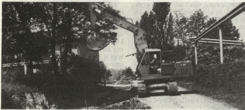
Rekonstrukcija ceste od križišča – Zdravstveni dom do ŠKIMC Štore, izkopi (foto Arzenšek)
