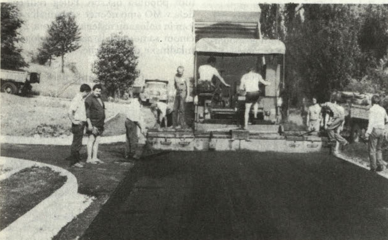
Asfaltiranje ceste – zaključna dela (foto Arzenšek)
