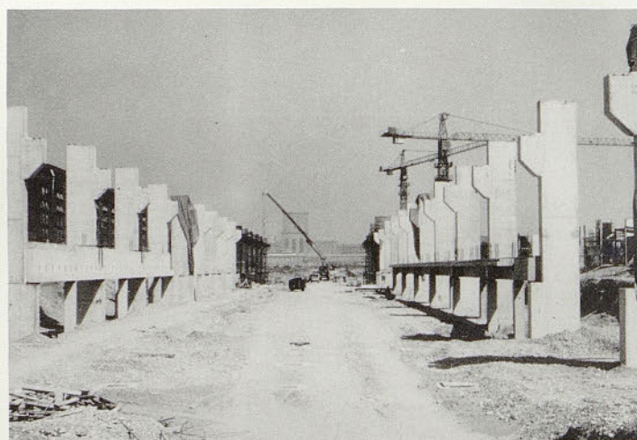
Nosilni stebri za halo št. 1
