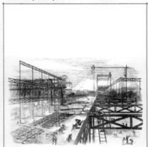
Slika 5: J. Paxton: sestavljanje stebrov in nosilcev za Kristalno palačo, London 1850 [McKean]
