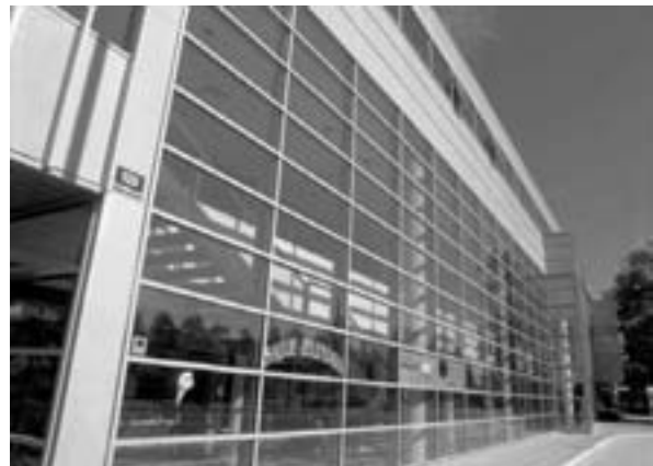
Slika 2b: polstrukturalna zasteklitev objekt na Dunajski, Ljubljana, (Schüco, sistem FW 60 + )
