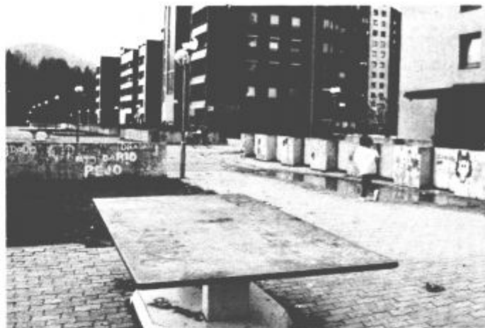
Ploščad nad parkirišči ni tehnično prevzeta niti po dvanajstih letih. Grajena ni za promet, pa vendar je na njej polno vozil.
