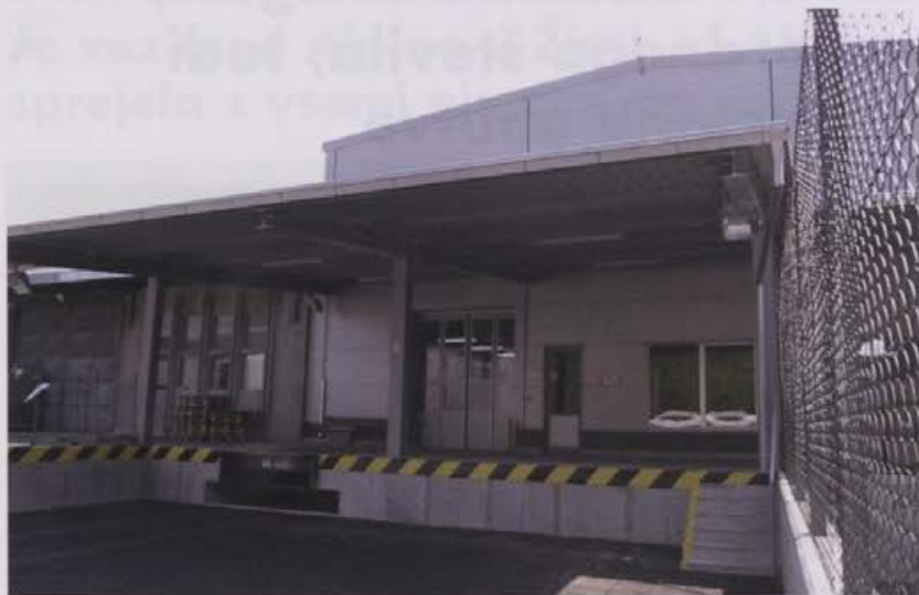
Sodobno urejen vhod v novo skladiščno halo
