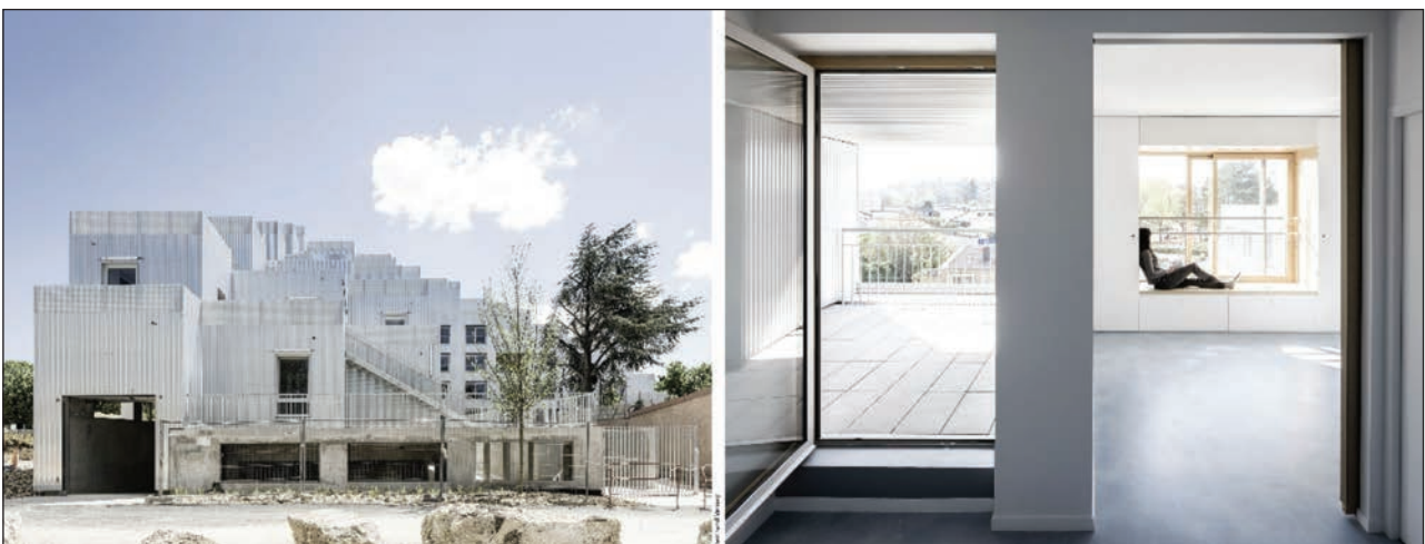
Figure 8: Grand Dijon Habitat, Sophie Delhay architecte (Photos: Bertrand Verney, 2019).
