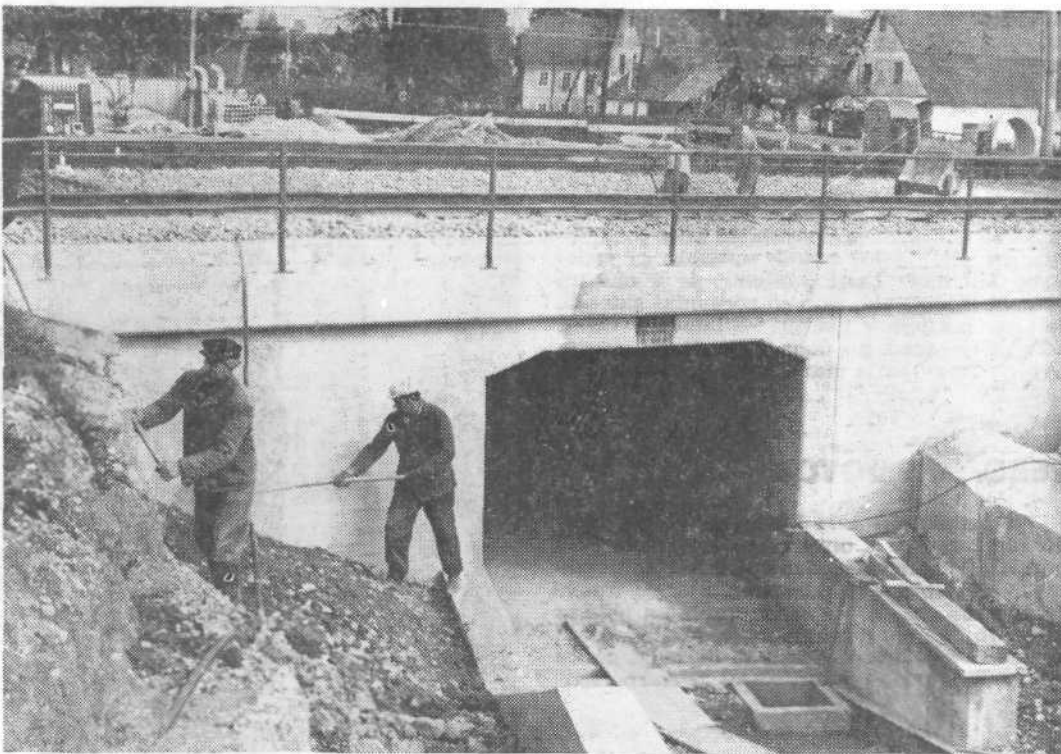
Delavci Železniškega gradbenega podjetja zaključujejo dela pri graditvi podhoda pod železniško progo na cesti Medvode—Preska (na fotografiji). Podhod bo imel dva metra široke stopnice za pešce in meter široko kolesarsko stezo. Računajo, da bo podhod že v novembru predan namenu.
