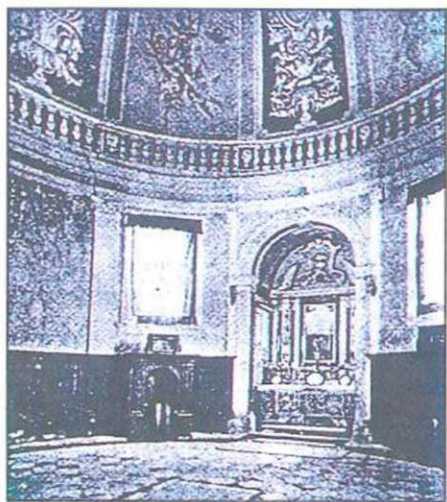
Sl. 5: Baročna notranjščina rotunde (MZVNKD Piran). Fig. 5: Baroque interior of the rotunda.
