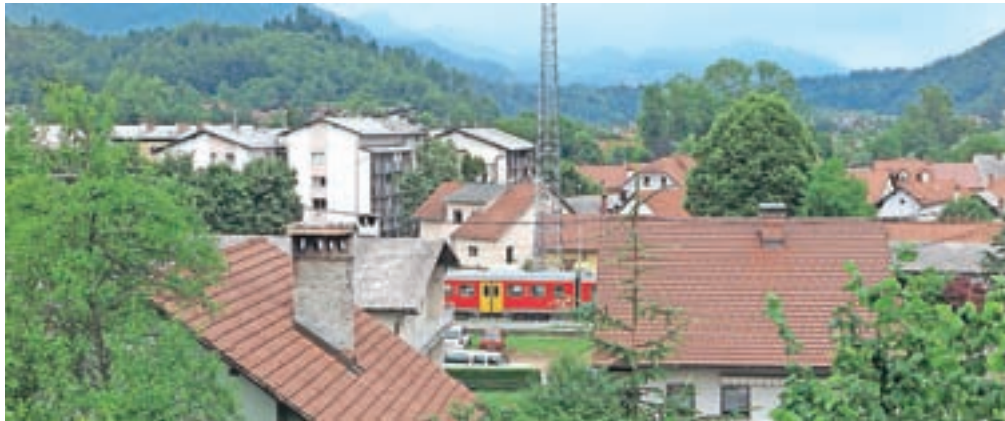
Bazna postaja Slovenskih železnic je bila na Železniški postaji Kamnik Graben postavljena pred skoraj štirimi leti, vse od takrat pa tamkajšnje stanovance zelo moti. / FOTO: JASNA PALADIN
