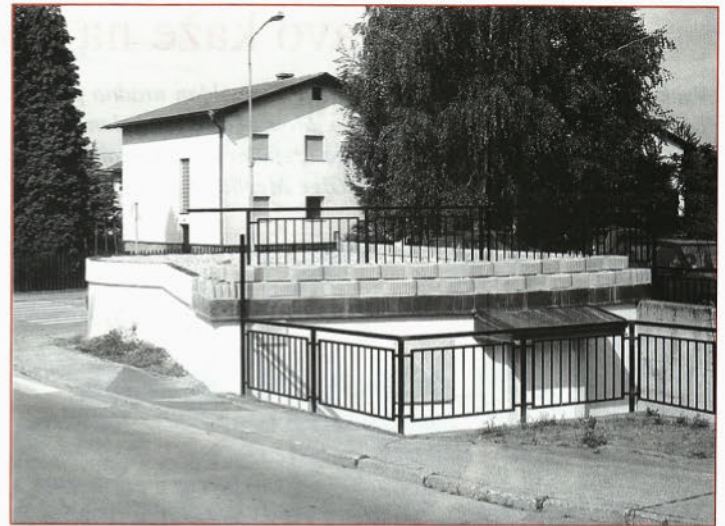
Rimsko opekarsko peč so zaščitili z betonsko lupino.
