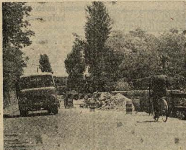
Na Cesti herojev, ki je najvažnejša vpadnica v Novo mesto, so začeli popravljati del cestišča, ki se je že pred nekaj časa začel podajati proti Krki. To ozko grlo, ki je zaradi omejitev hitrosti zahtevalo od marsikaterega voznika tisočaka, bo končno popravljeno (Foto: M. Vesel)
