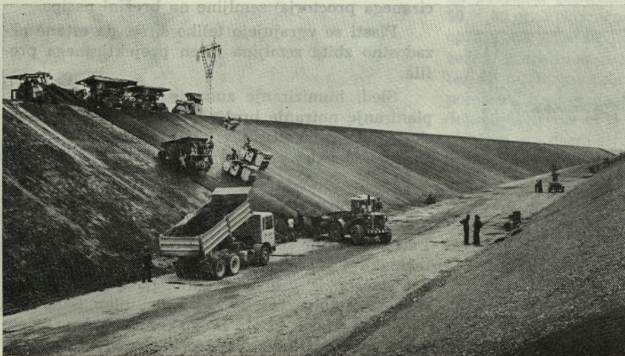
Sl. 10. Asfaltiranje brežine dovodnega kanala
