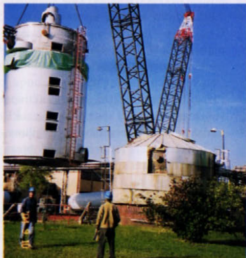
Pogled na prestavitev 68 ton težkega ohišja kotla
