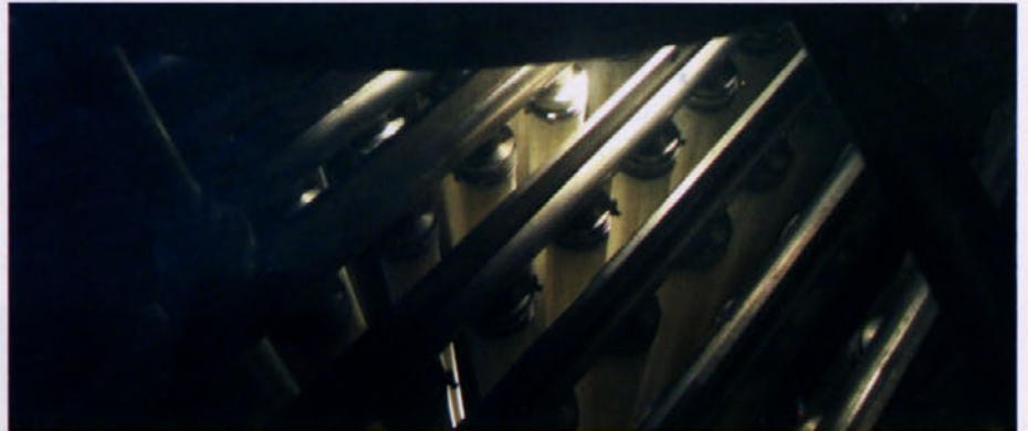
Tako izgleda filter Fundabac po avtomatskem pranju
