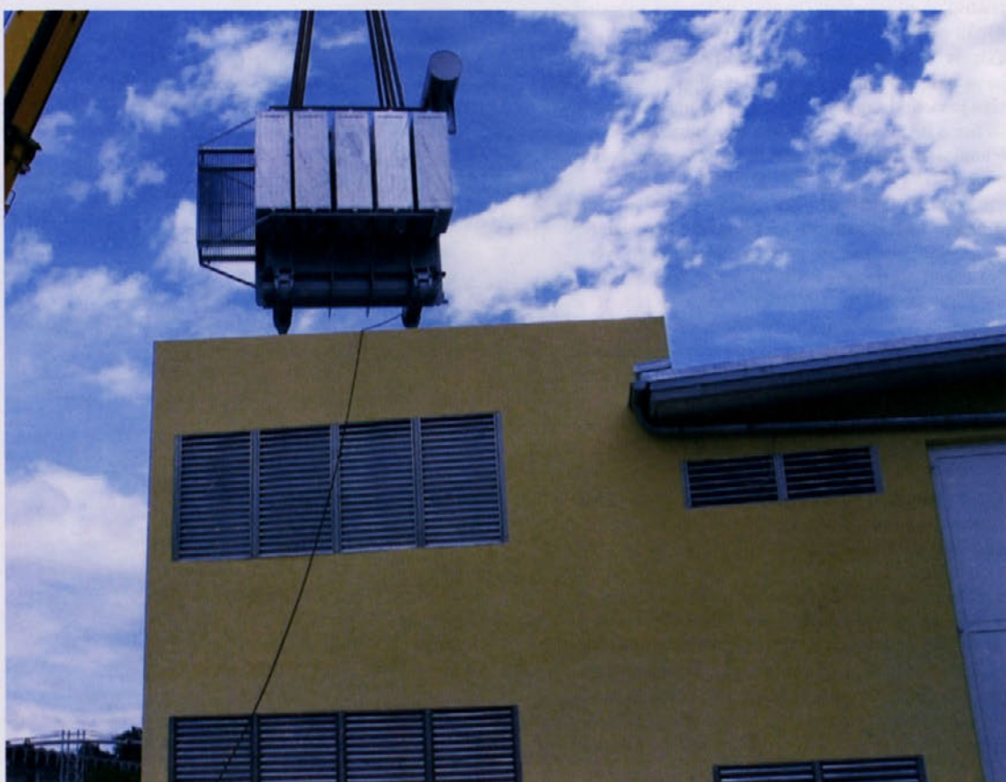
Montaža novega transformatorja moči 20 MVA v trafo boks nove RTP TiO 2
