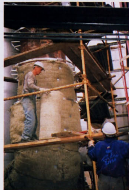
Izvedba visokokvalitetne izolacije
