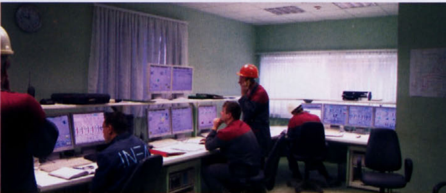
Vodenje celotnega procesa na filtrih Fundabac poteka iz na novo urejene Kabine 2
