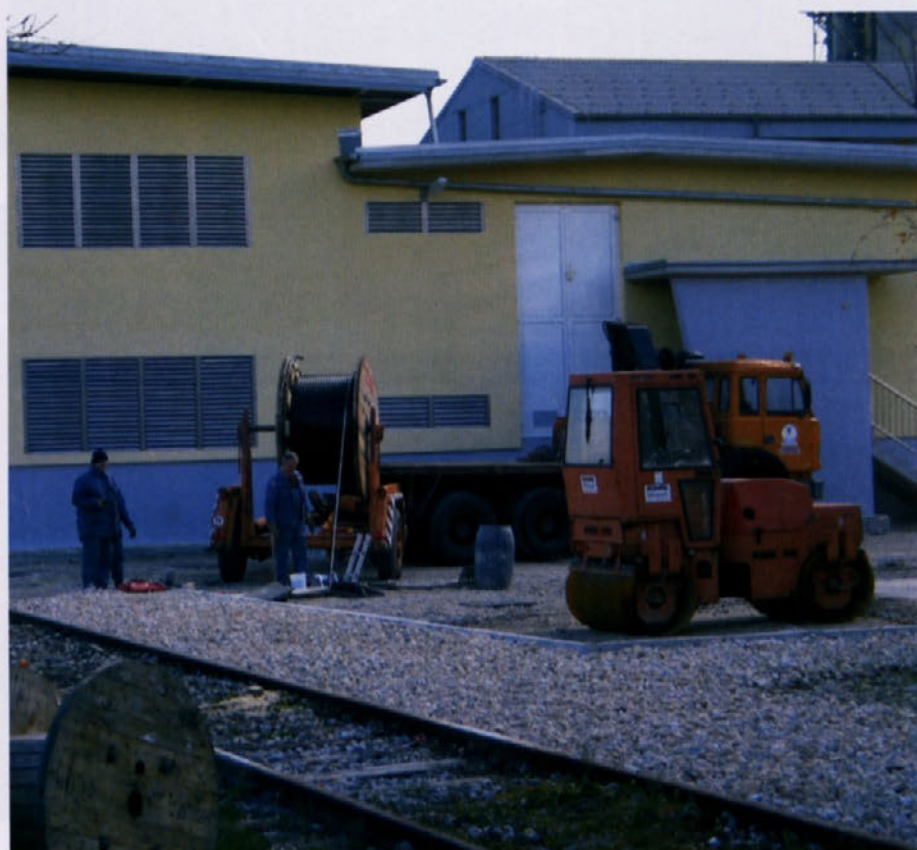
Polaganje novih napajalnih kablov za Cinkarno - v ozadju nova RTP TiO 2
