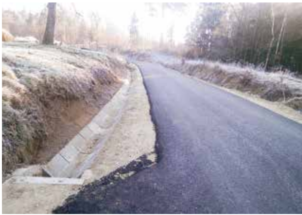
Rekonstrukcija ceste Beli križ – Kuftovi (foto: M. Žokš)
