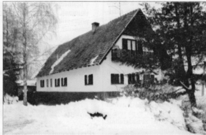
Potrčeva domačija stoji samo dva kilometra od Ptuja ob cesti proti Mariboru prek Vurberka.
