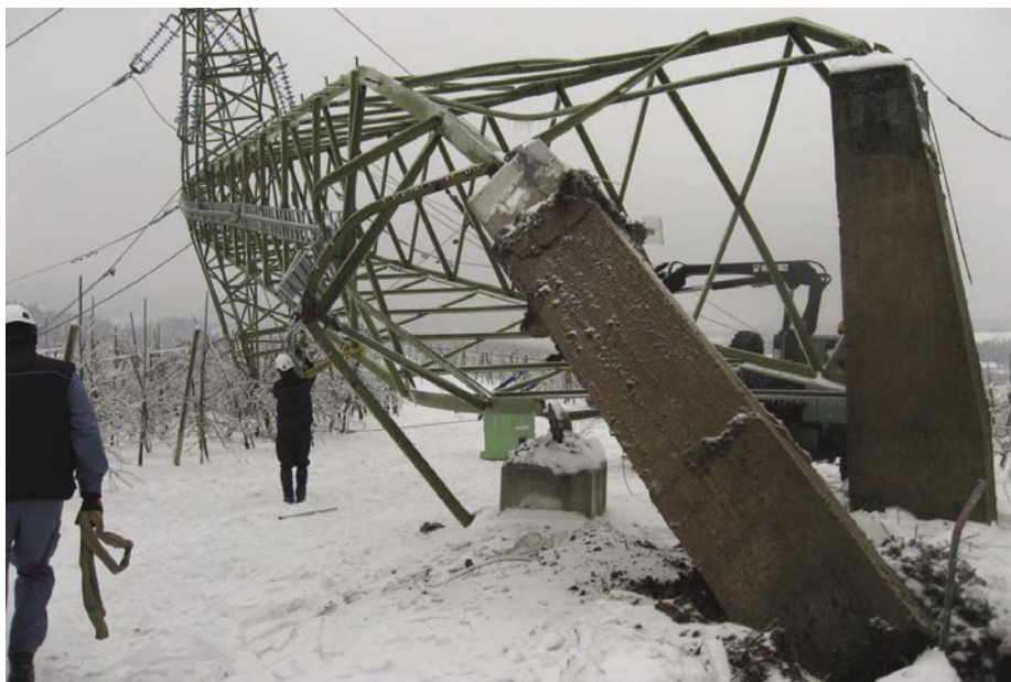
Slika 14 • Izvlek temelja na SM 122 DV 2 x 110 kV Velenje–Slovenj Gradec
