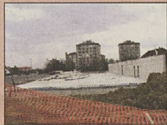
Gradbišče marketa Lidl sameva
