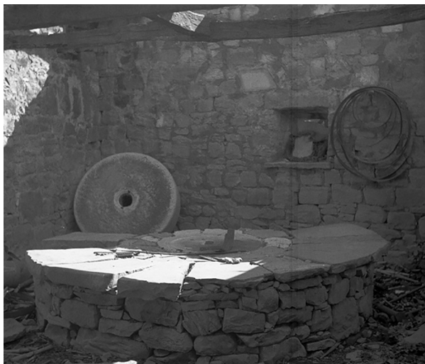
Slika 16 Ostanke novoveške krožne zidane podlage za mlin iz bližnjega Lavorja.
