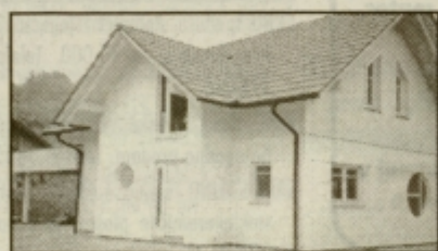
VOJNIK montažna stanovanjska hiša - 22 mio SIT
