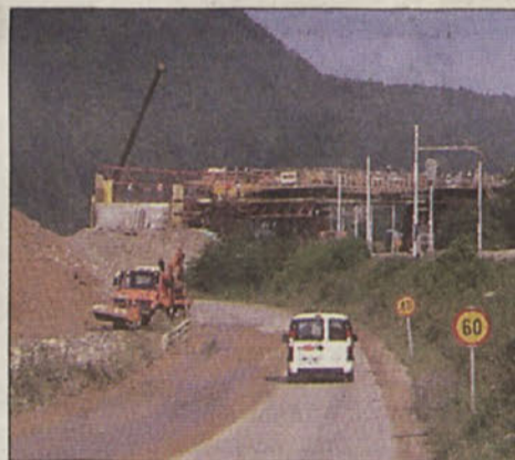
Izgradnja nadvoza pri Orehovem
