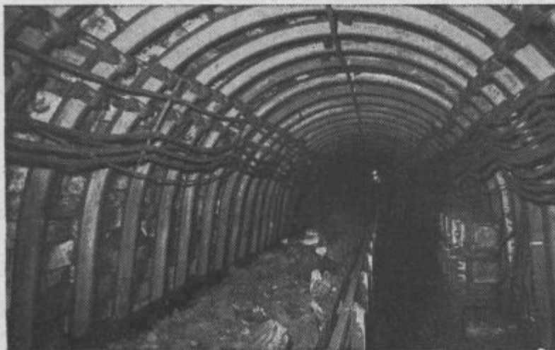
Jeklena podgrada z loki
