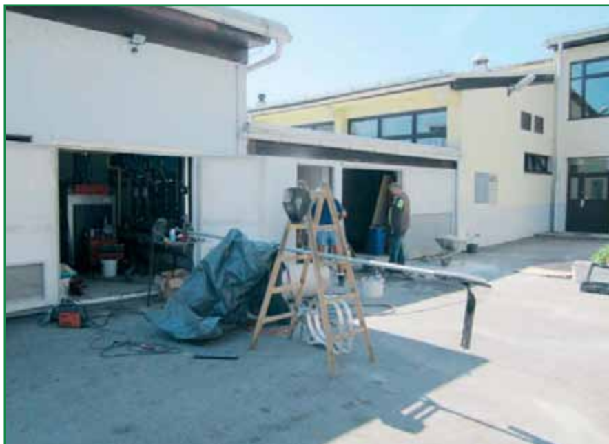
Obratovanje naprave je predvideno v času ogrevalne sezone.
