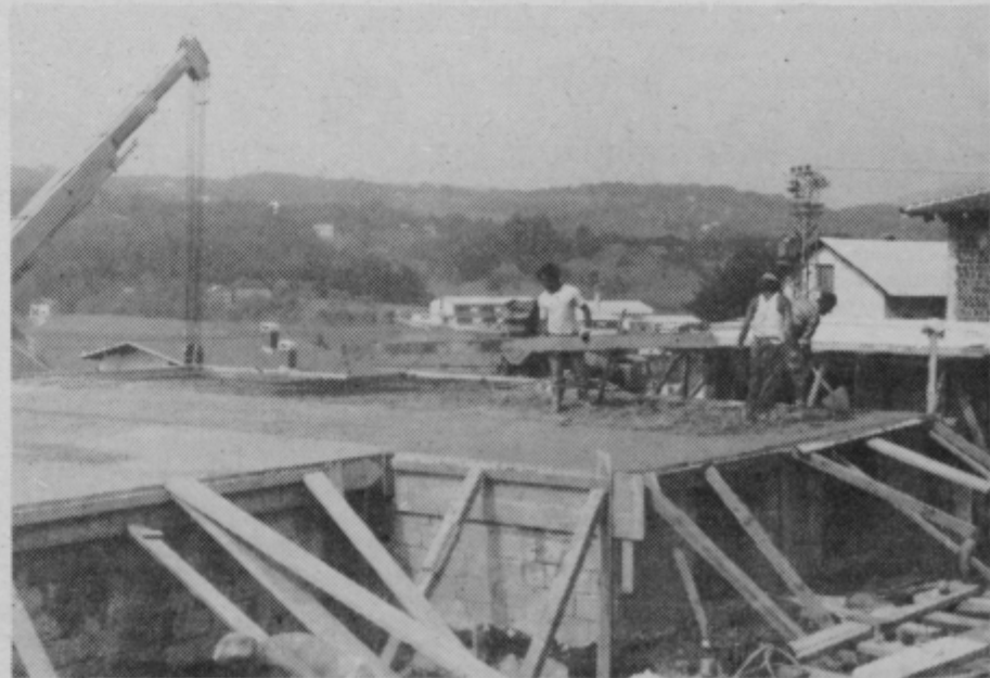
Delavci, zaposleni pri družinah Samec - Vajčer pri gradnji stanovanjske hiše
