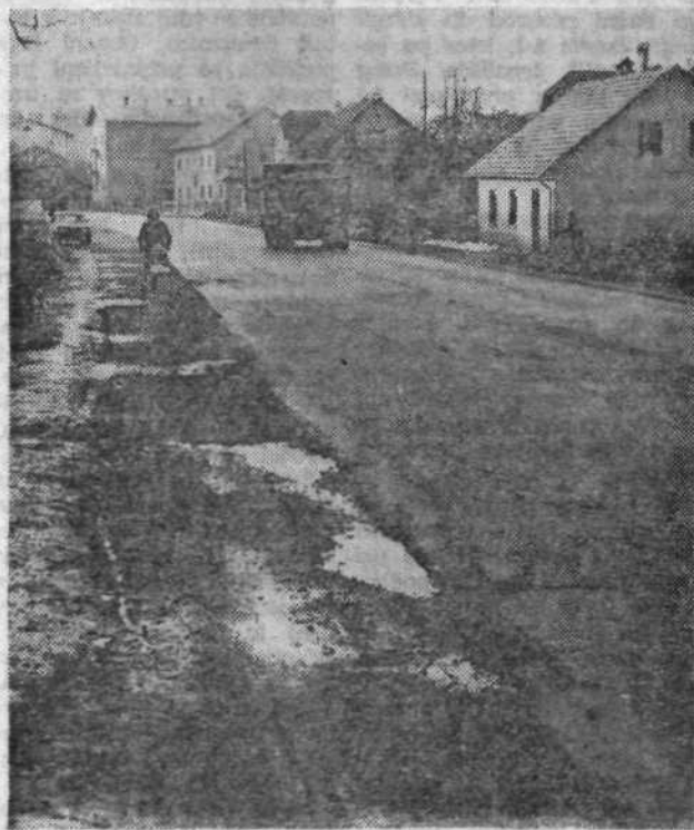
Na Črnučah bodo asfaltirali pas za počasni promet od zadnje postaje do nove bencinske črpalke na koncu naselja.
