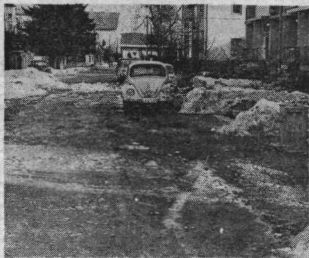
Zagreško ulico bodo asfaltirali, uredili bodo tudi cestno razsvetljavo. Kanalizacija je bila zgrajena že lani.
