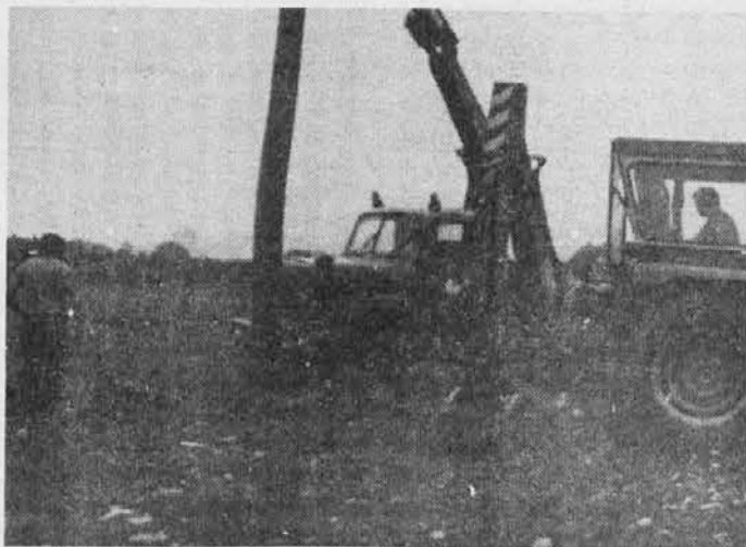
Delavci krškega Elektra so takoj začeli odstranjevati daljnovodne žice z njiv
