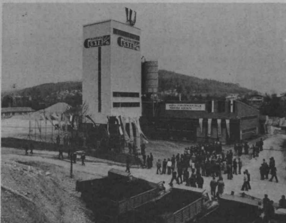
Za komandnim pultom tovarne asfalta SGP Slovenija ceste na Črnučah bosta le dva delavca. S pritiski na gumbe bosta obvladala proizvodnjo 300 ton asfaltne mešanice na uro.
