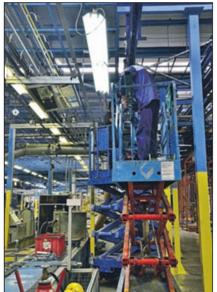
Kakovosti namenjajo v Gorenju veliko pozornosti. Na sliki montaža transporterja za vakumiranje in podaljšano testiranje aparatov, s čimer bo dosežen 100-odstotni učinek v toplotni črpalki sušilnega stroja.
