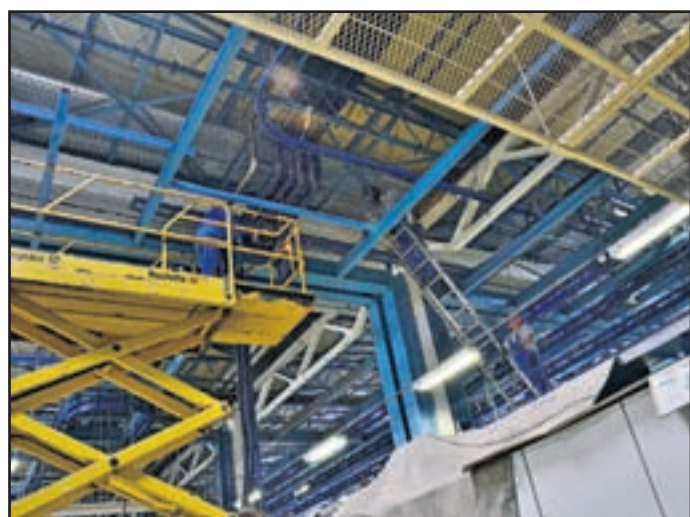
Montaža konstrukcije visečega transporta za prevoz ohišij do lakirnice
