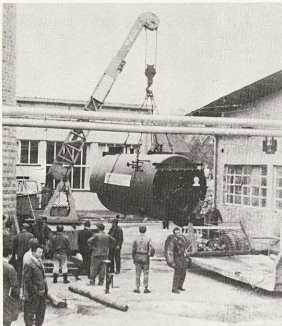
Začetek rekonstrukcije kotlarne
