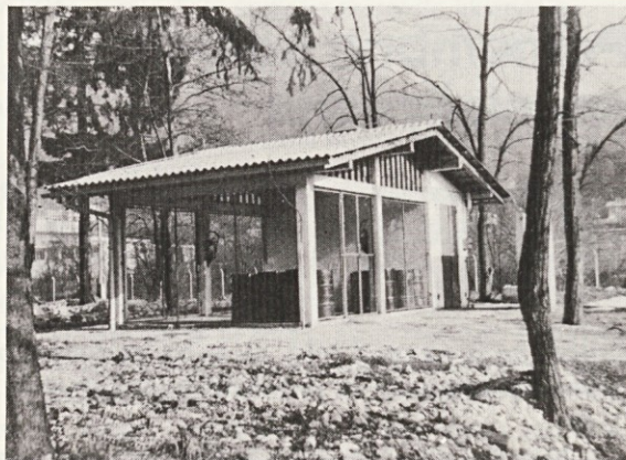
Skladišče vnetljivega materiala
