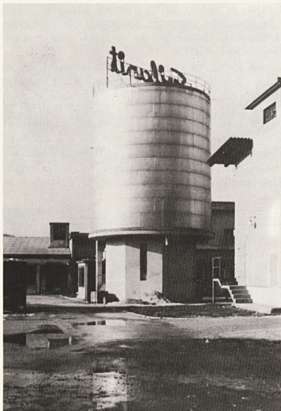
Rezervoar za tehnološko vodo
