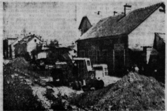
Na Ljutomerski cesti so v te ku pripravljala dela
