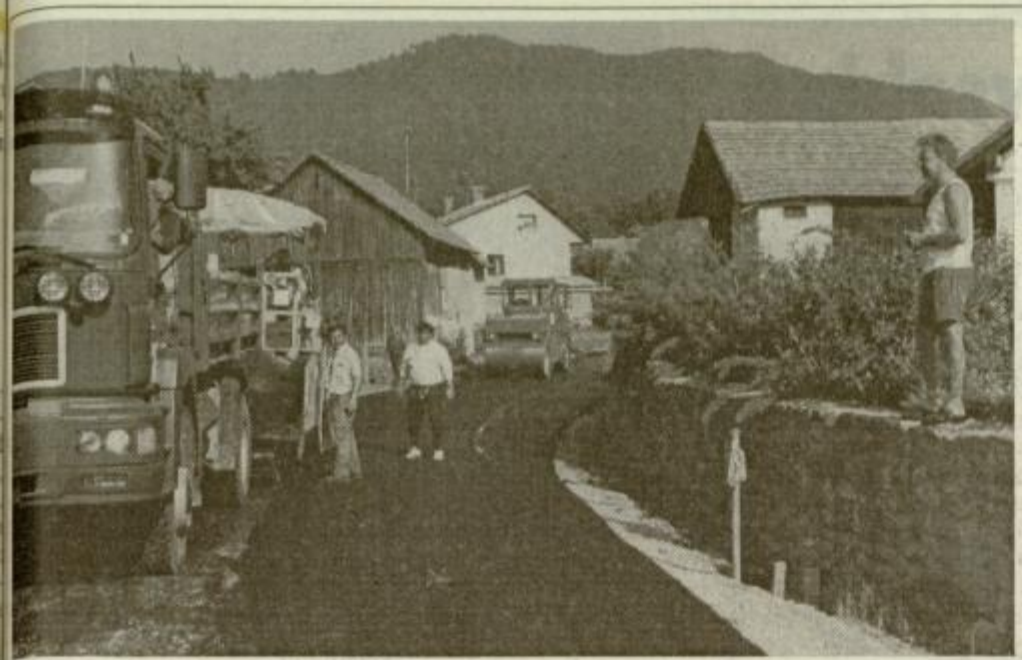
V soboto so asfaltirali razširjeno cesto v Rakovljah.
